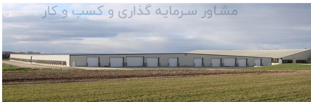
شکل شماره ۱۶. نمایی از یک سالن فری استال با تهویه عرضی که فن ها بر روی دیوار طولی سالن نصب شده اند.
